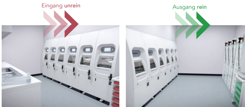
Beladeseite Trennung durch massive Wand Entladeseite
