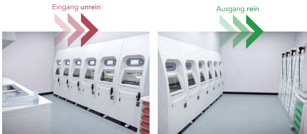
Beladeseite Trennung durch massive Wand Entladeseite
